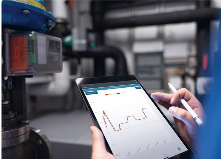
Neben Angaben wie der Betriebszeit und der Anzahl der Lastspiele können die Werte der Elektroniktemperatur und des Schleifenstroms sowie ein Soll/Istwert-Abgleich der Ventilstellung als Diagramm aufgezeichnet werden. Diese Diagramme können natürlich anschließend gespeichert und zur weiteren Auswertung versendet werden. Auch aktuelle Werte, Einstellungen und Diagnosedaten stehen in der App zum Herunterladen bereit. Und damit alles, was eine Analyse braucht oder der Support per Mail erfordert.
